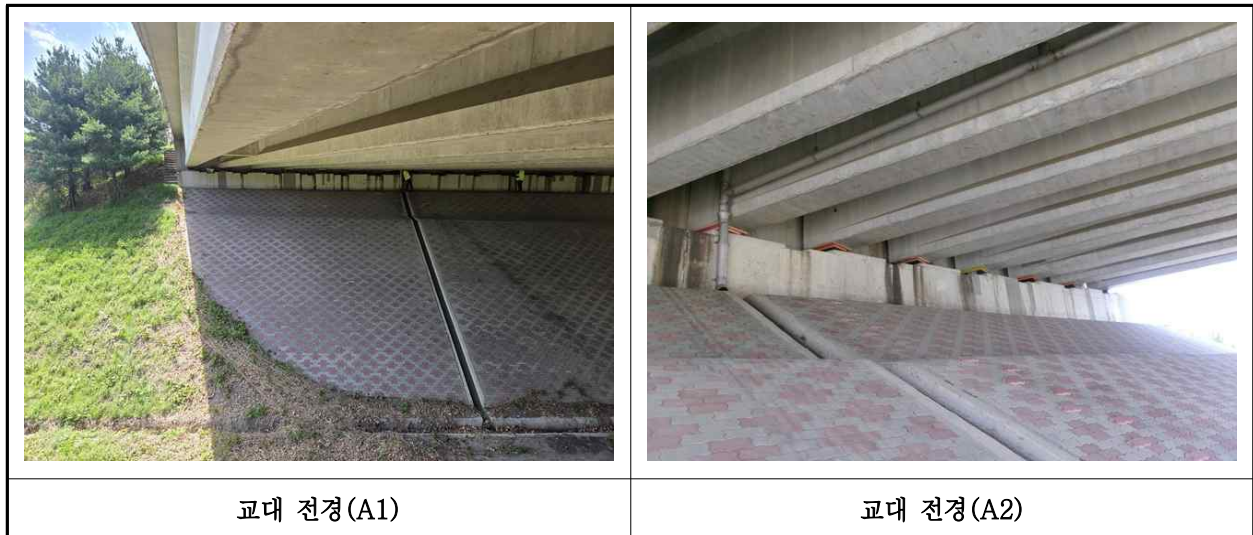
【사진 8.3.8】 교대 전경
