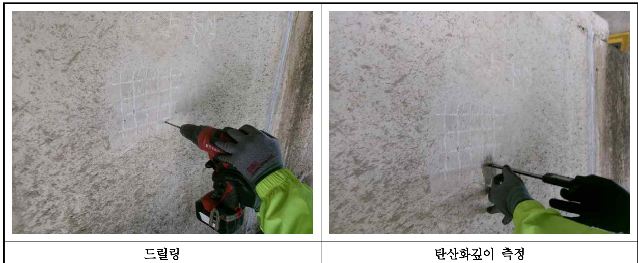
【사진 8.4.3】 탄산화 깊이 측정 현장사진
