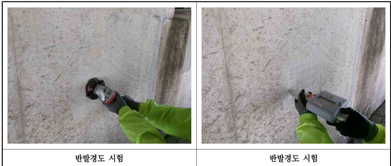
【사진 8.4.2】 반발경도시험 현장사진
