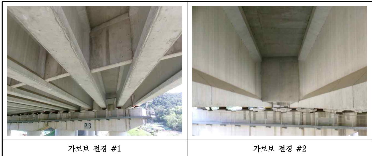
【사진 8.3.6】 가로보 전경
