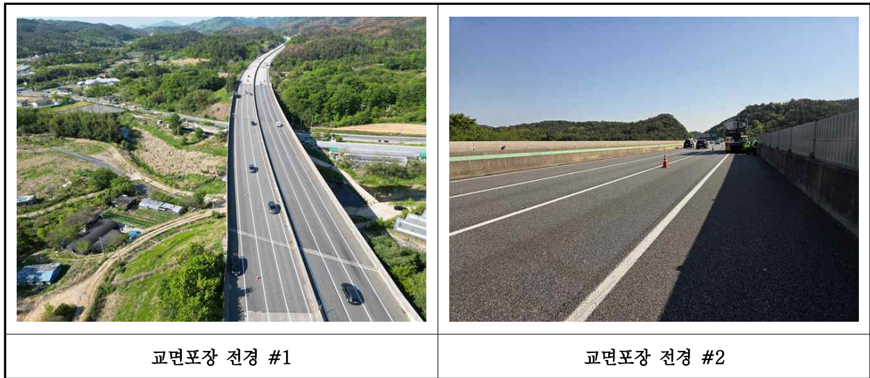
【사진 8.3.20】 교면포장 전경
