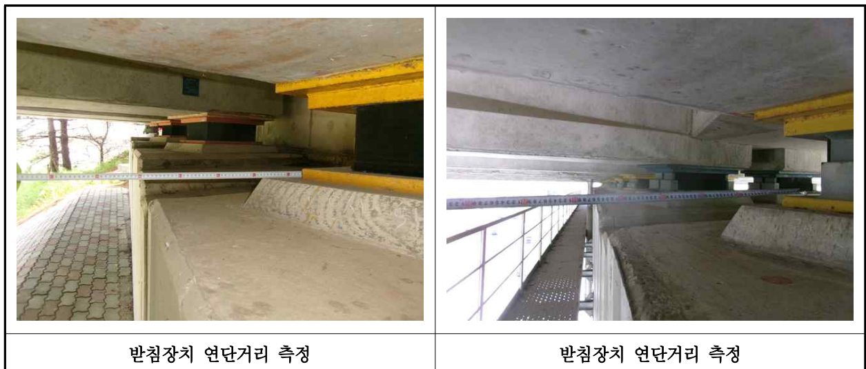
【사진 8.3.15】 교량받침장치 연단거리측정
