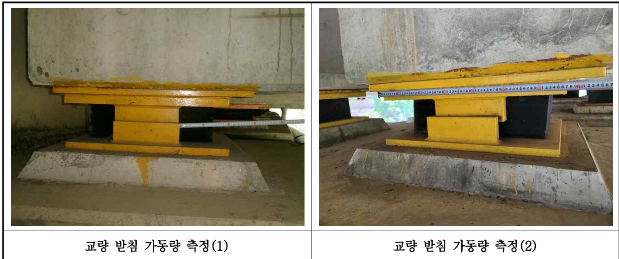
【사진 8.3.16】 교량받침 이동량 측정
