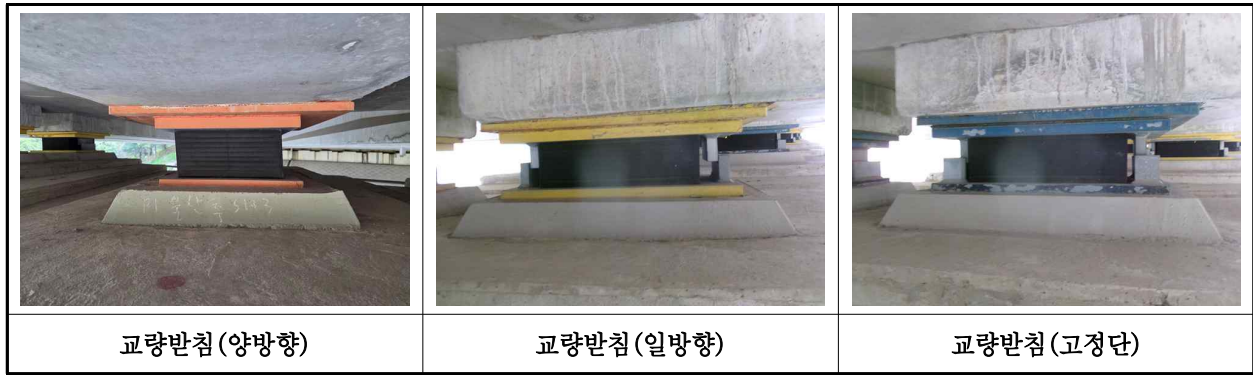
【사진 8.3.13】 교량받침 전경
