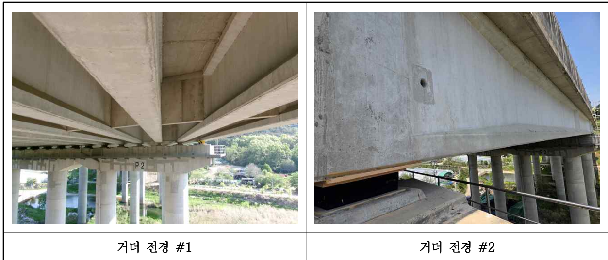
【사진 8.3.4】 거더 전경
