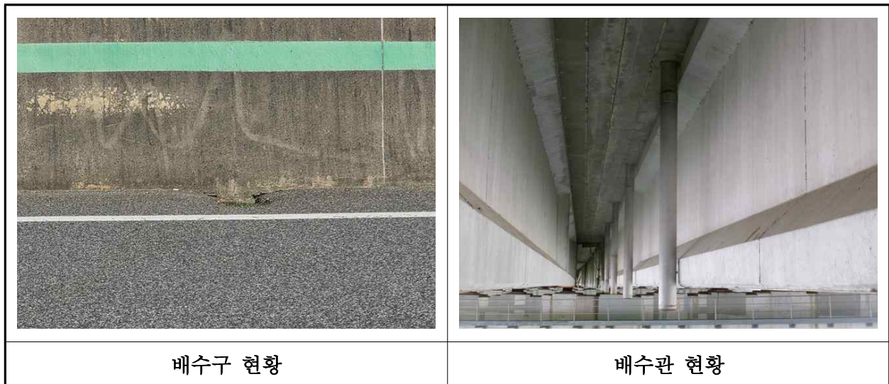
【사진 8.3.22】 배수시설 전경
