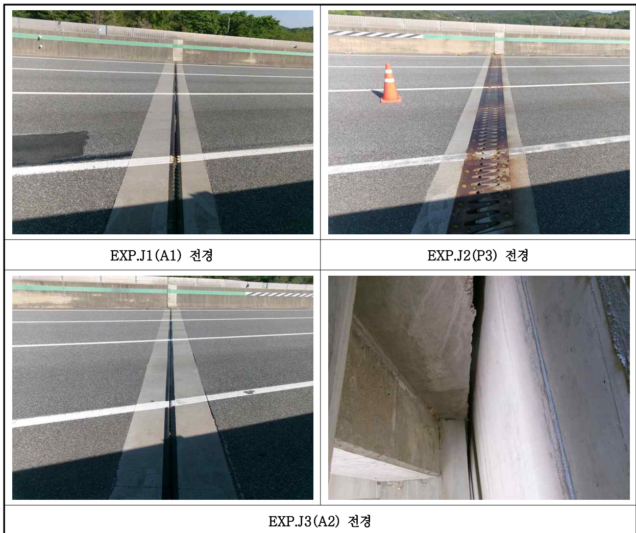
【사진 8.3.17】 신축이음장치 전경
